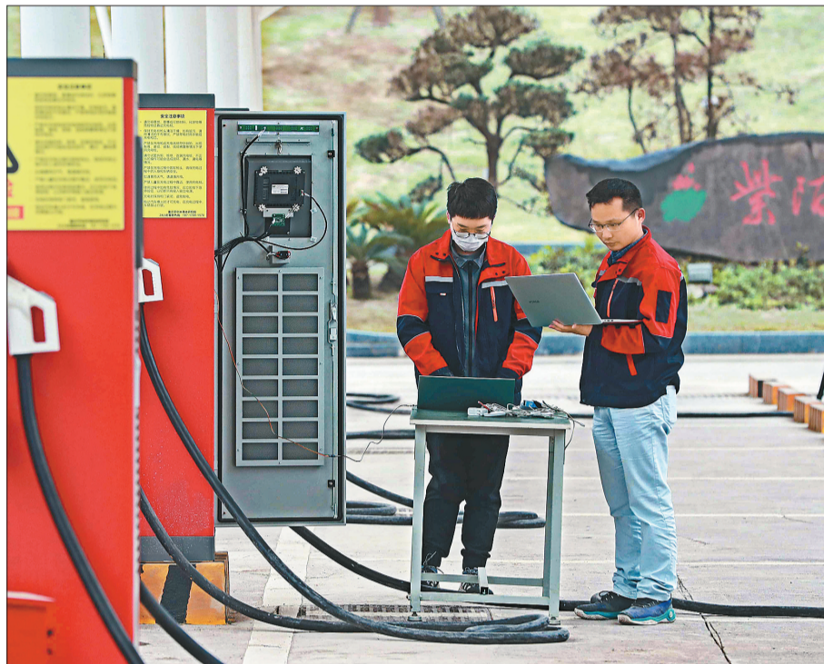
璧山高新区,重庆高新技术产业研究院的科技人员在调试新型碳化硅半导体充电桩。(摄于2021年2月18日)
