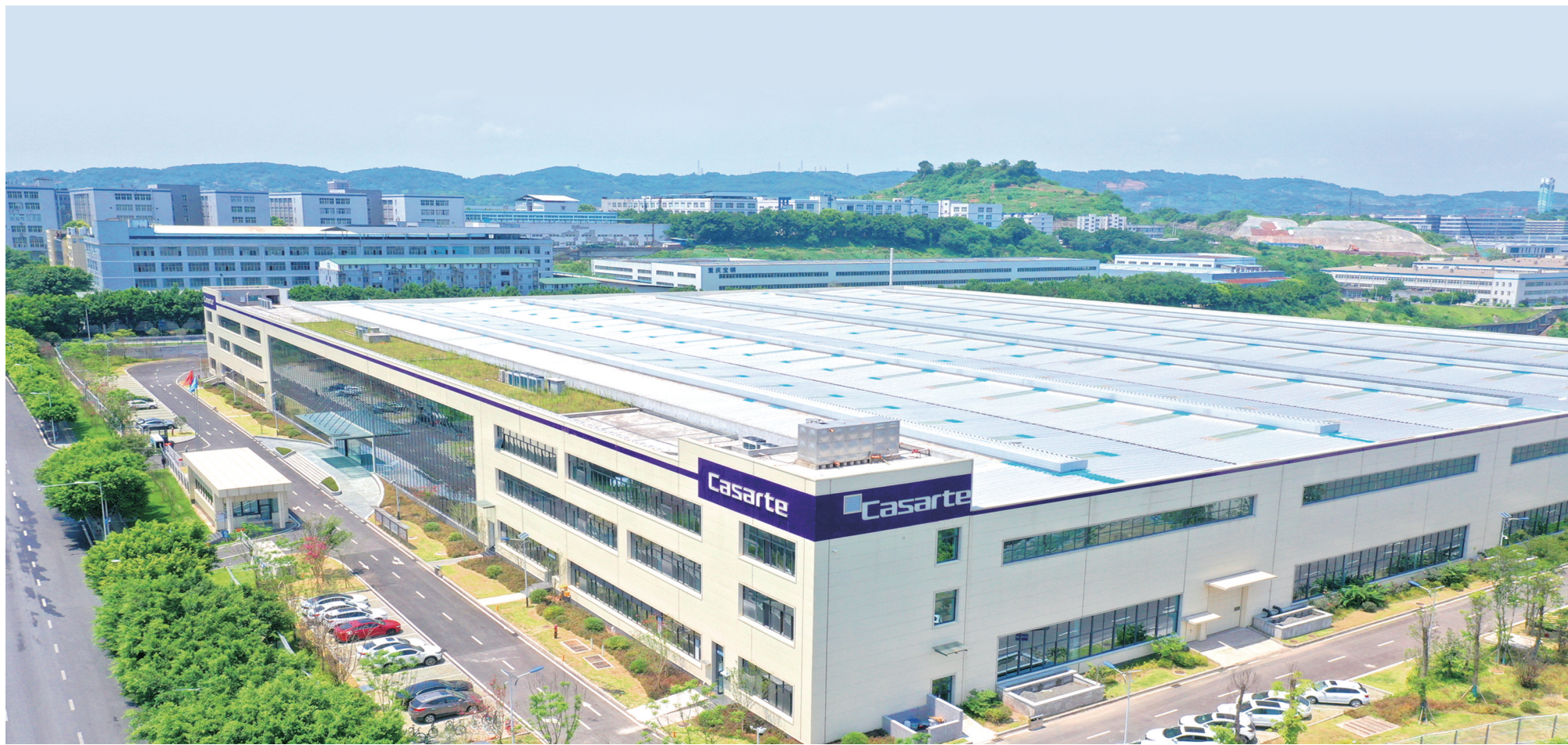
重庆海尔洗碗机互联工厂创下6个月厂房建成、10个月生产投用的“加速度”,刷新了海尔集团国内外项目建设的记录
