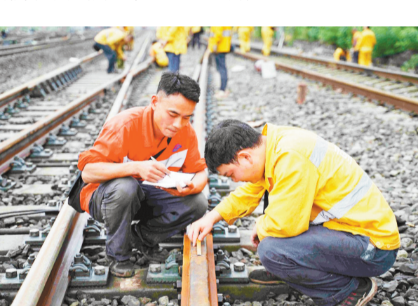
施工作业现场。（受访者供图）
