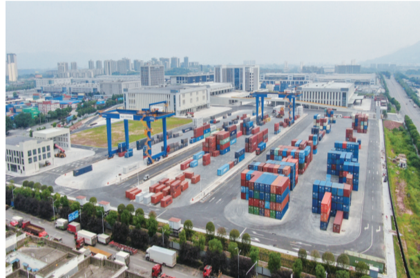
西部陆海新通道重庆无水港项目 摄/郭晋
